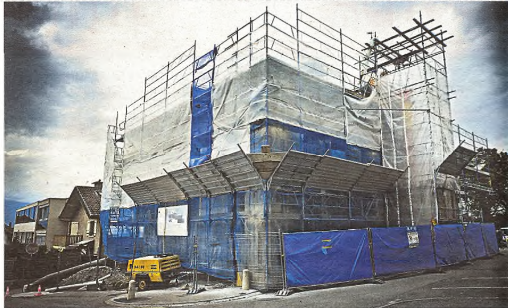
L'ancienne mairie du Grand-Saconnex, bientôt transformée en école, est isolée à l'aide de plaques d'herbes.
